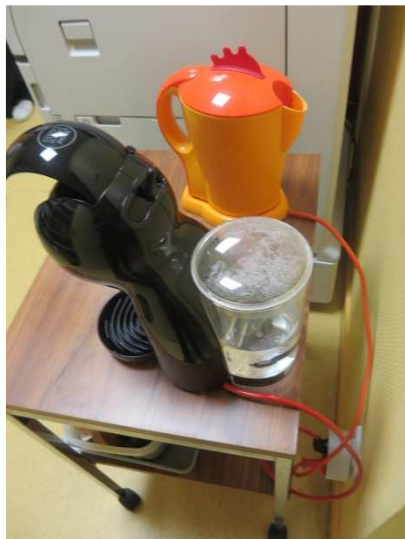
A gauche, fiche multiple constatée dans une installation informelle au sein d'un bureau du bâtiment.
